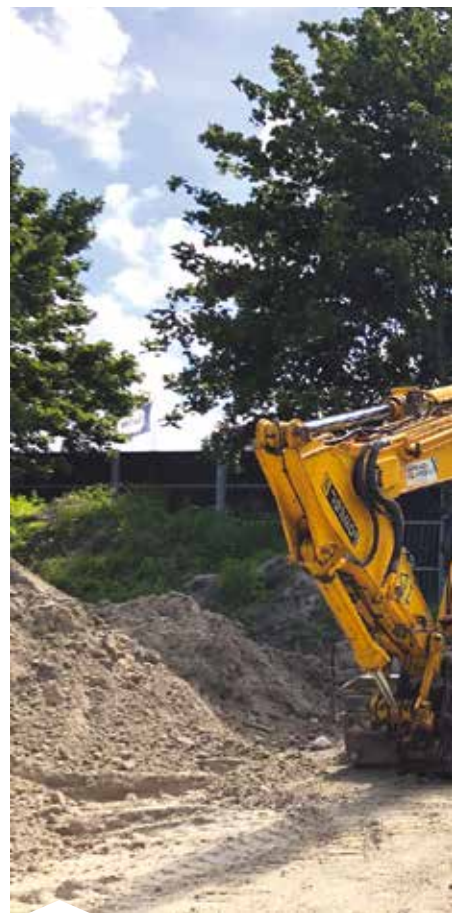
Gennem en række udbud får Aalborg Kommune konkret erfaring med omstilling til fossilfrie byggepladser ved at stille krav om, at maskiner på byggepladser skal være eldrevne eller køre på HVO 100.
